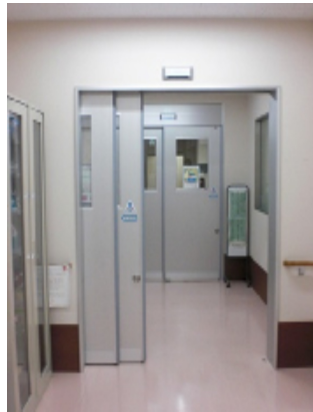
結核ユニットへの2重扉
